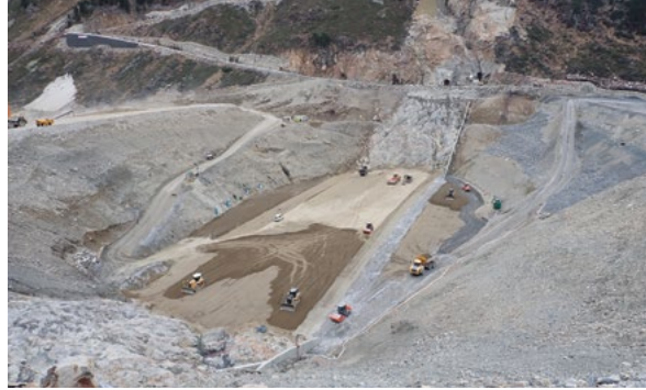
Herbst 2022 Arbeiten am Dichtkern des Steinschüttdamms am Ende der ersten Schüttsaison
