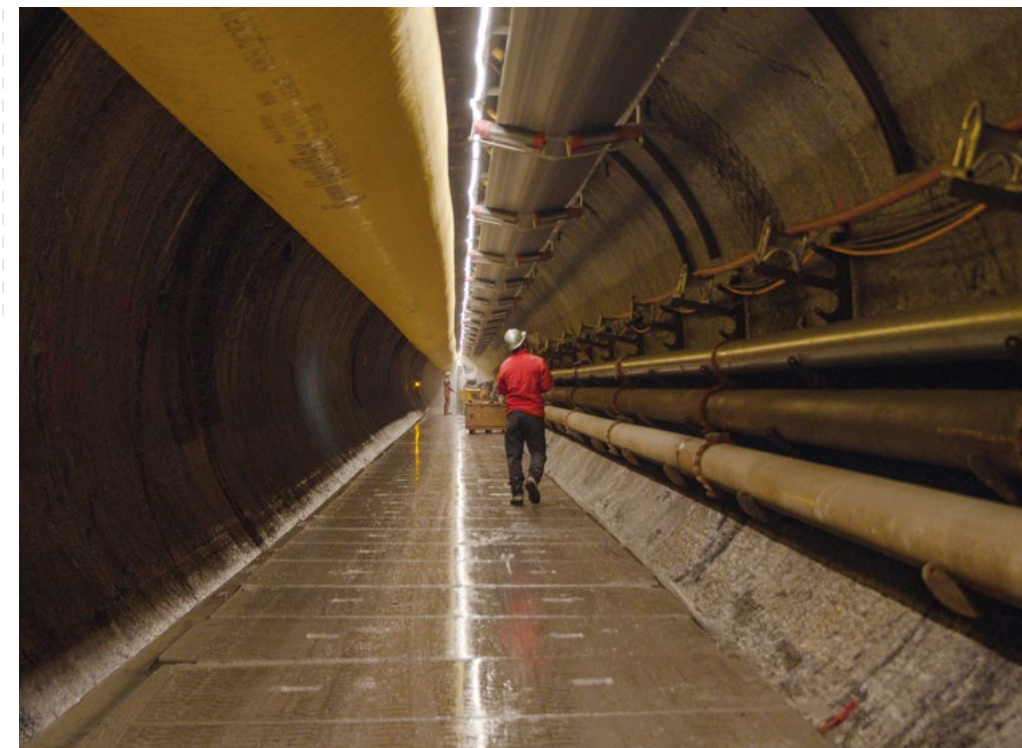
+ Inspektion des bereits hergestellten Teils des Beileitungsstollens in der Bauphase
