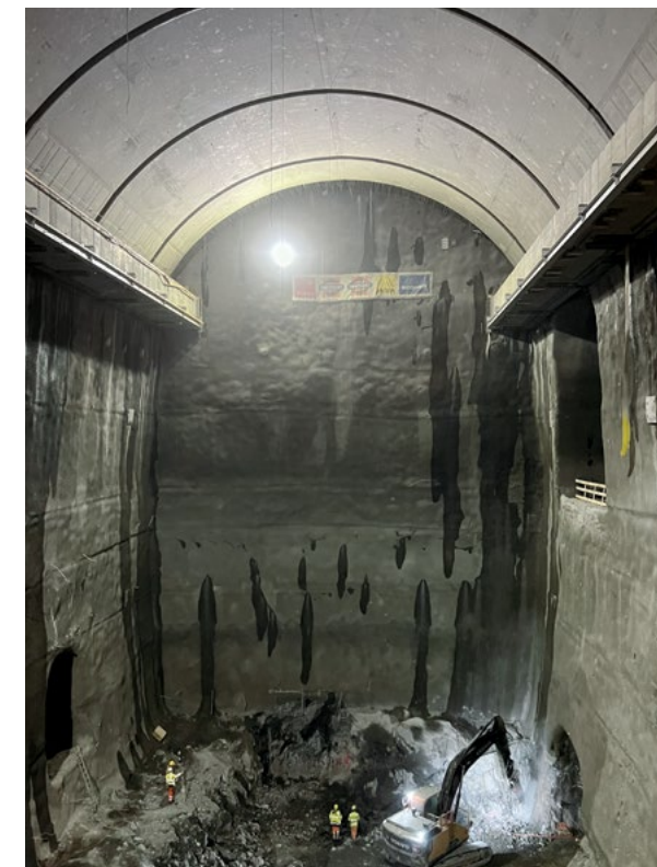
Frühjahr 2023 Der aus dem Fels gesprengte Hohlraum für das Kraftwerk
