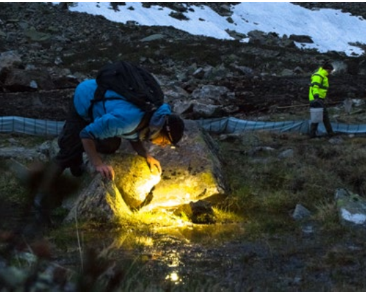
September 2019 Baubeginn Vorarbeiten
