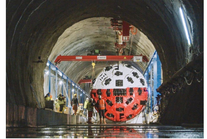
+ Die Tunnelbohrmaschine ALESJA wird auf ihren Einsatz vorbereitet
