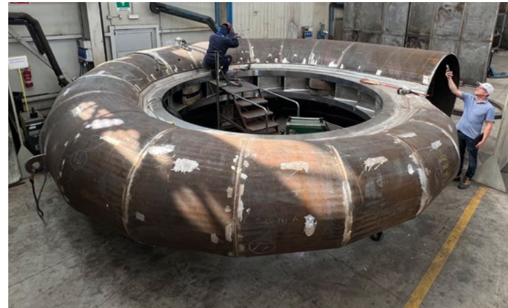
Juni 2023 Die Stahlbauarbeiten an den Spiralen der Pumpturbinen laufen parallel zum Bau plangemäß
