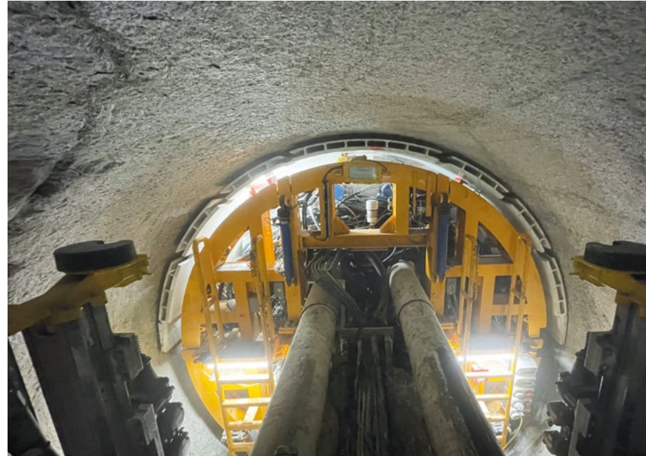
+ Der Beileitungsstollen unmittelbar hinter dem Bohrkopf der Tunnelbohrmaschine
