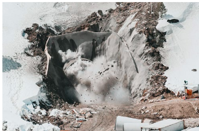
April 2021 Baubeginn Hauptbauarbeiten Kühtai
