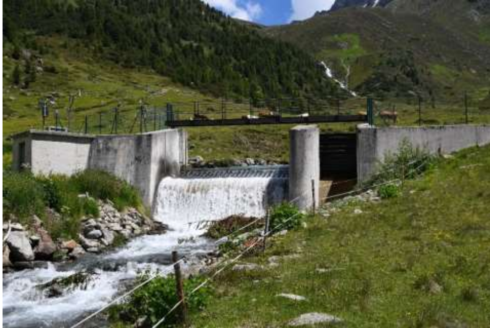
Wasserrfassung Horlachbach bei Überwasser
