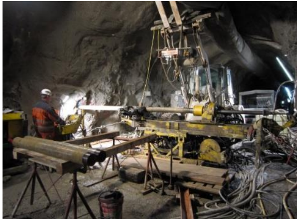
Erkundungsbohrung im Sondierstollen Klasgarten bei den Planungen
